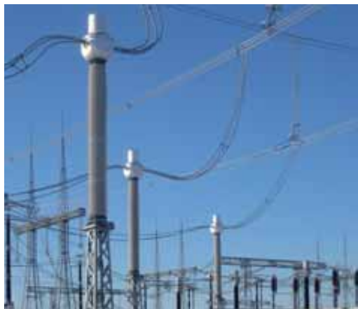
1. Transformador de corrente de 765 kV. RAO-FSK (Rusia).
