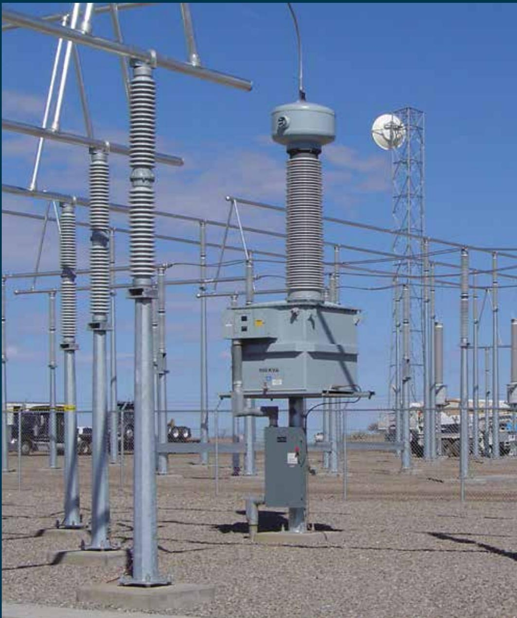
› Transformador para serviços auxiliares da subestação modelo UTP de 245 kV. Coyote Switch (EUA).
