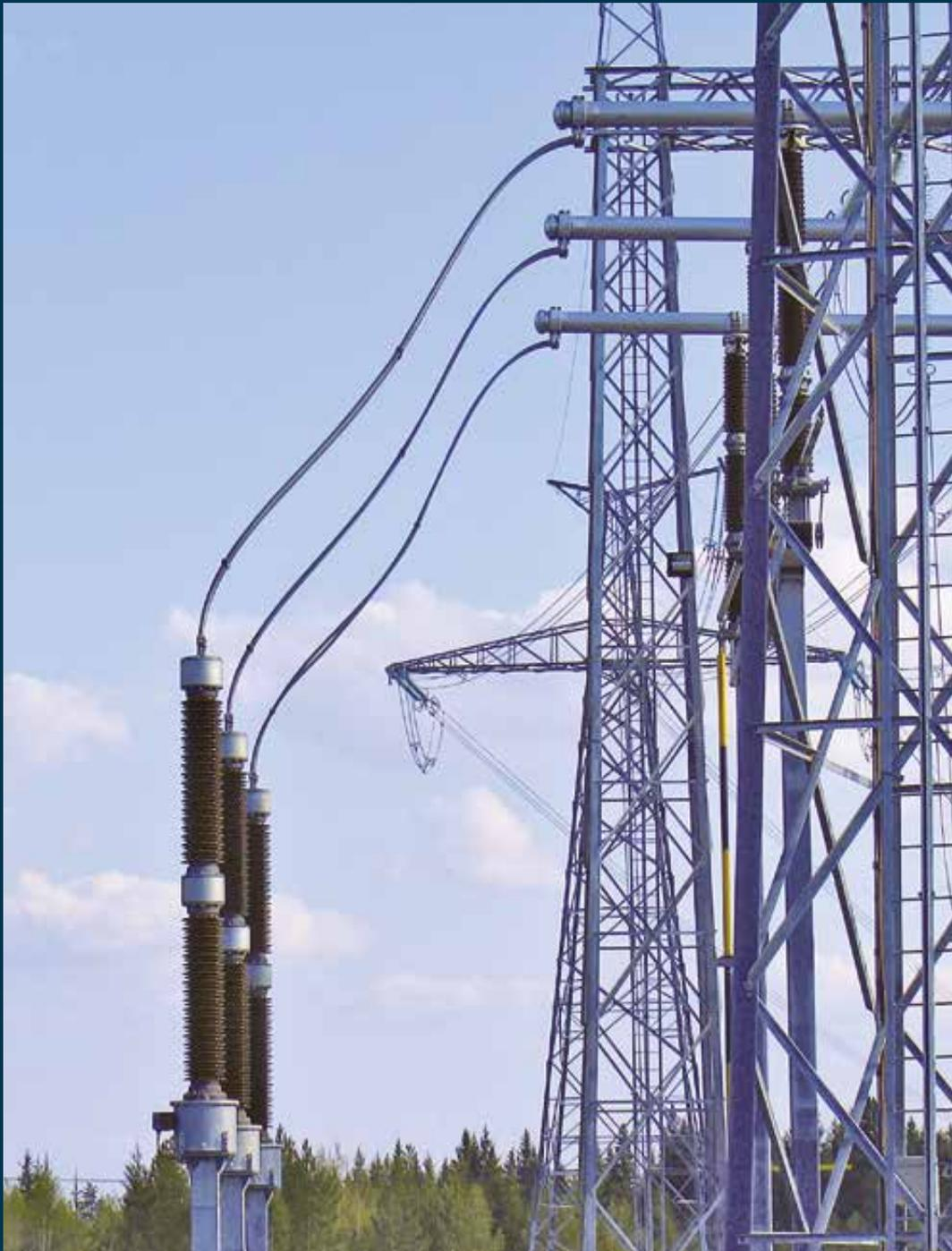
› Transformadores de potencial capacitivos de 420 kV. Fingrid, Visulahti (Finlândia).
