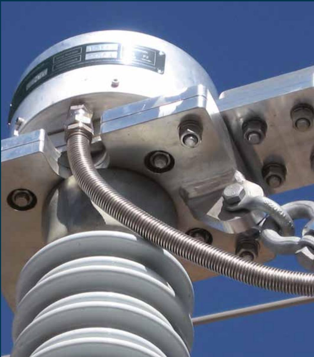
› Transformador de corrente óptico SDO OCT.
