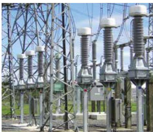
2. Transformadores de potencial indutivos de 123 kV. Transpower (Nova Zelândia).
