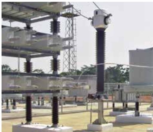
2. Transformador de corrente de 245 kV protegendo banco de capacitores (Índia).
