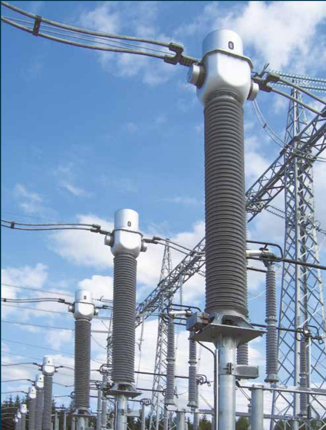
› Transformadores de corrente de 420 kV com isolamento de silicone cinza. Statnett (Noruega).
