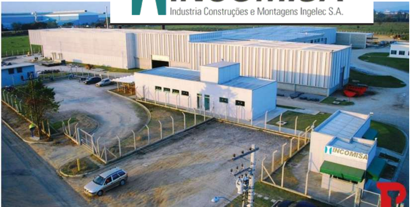
FÁBRICA VISÃO GERAL
