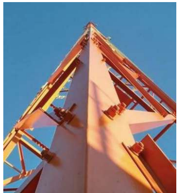
ESTRUTURA METÁLICA P/LINHA DE TELECOMUNICAÇÃO
